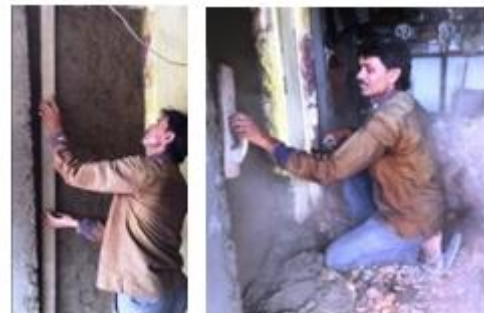
(i) (ii) (d) Level/plain the mortar (for inside plastering) (PL-4)
